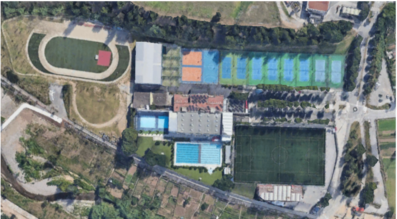
Vista general del Poliesportiu Municipal
